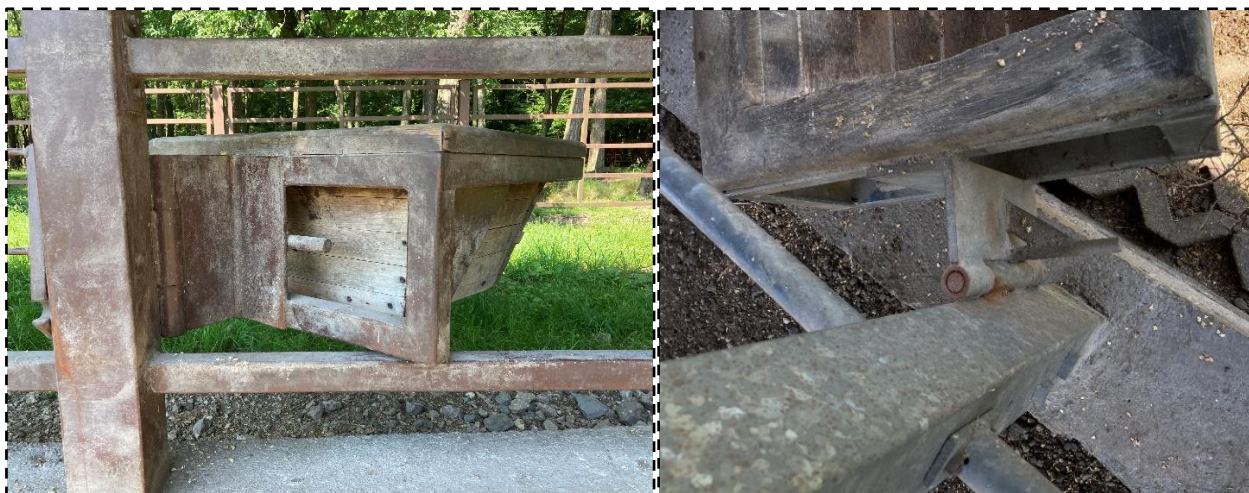
Przykładowe rozwiązanie konstrukcji tac oraz ich sposób montażu (Zagroda żubrów w Jankowicach)
